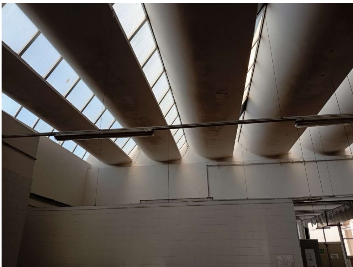
Figura 6: Vista interna infissi da sigillare
