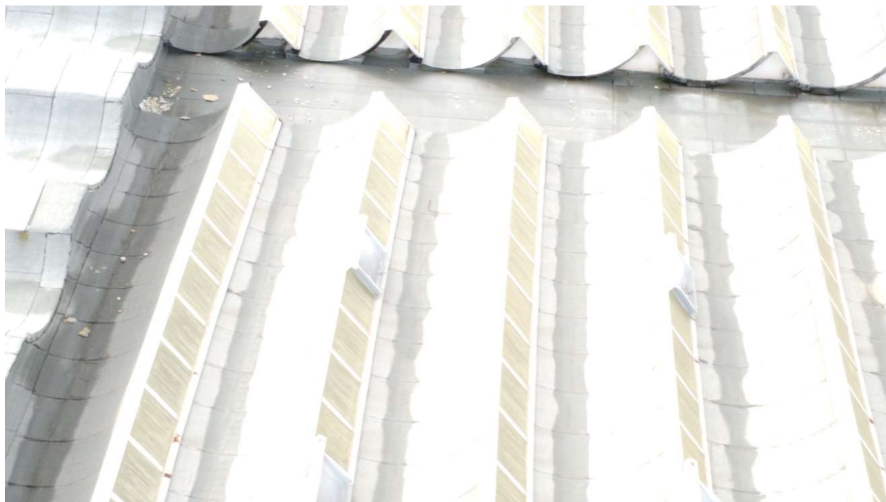
Figura 4: Particolare dello stato di fatto della copertura
