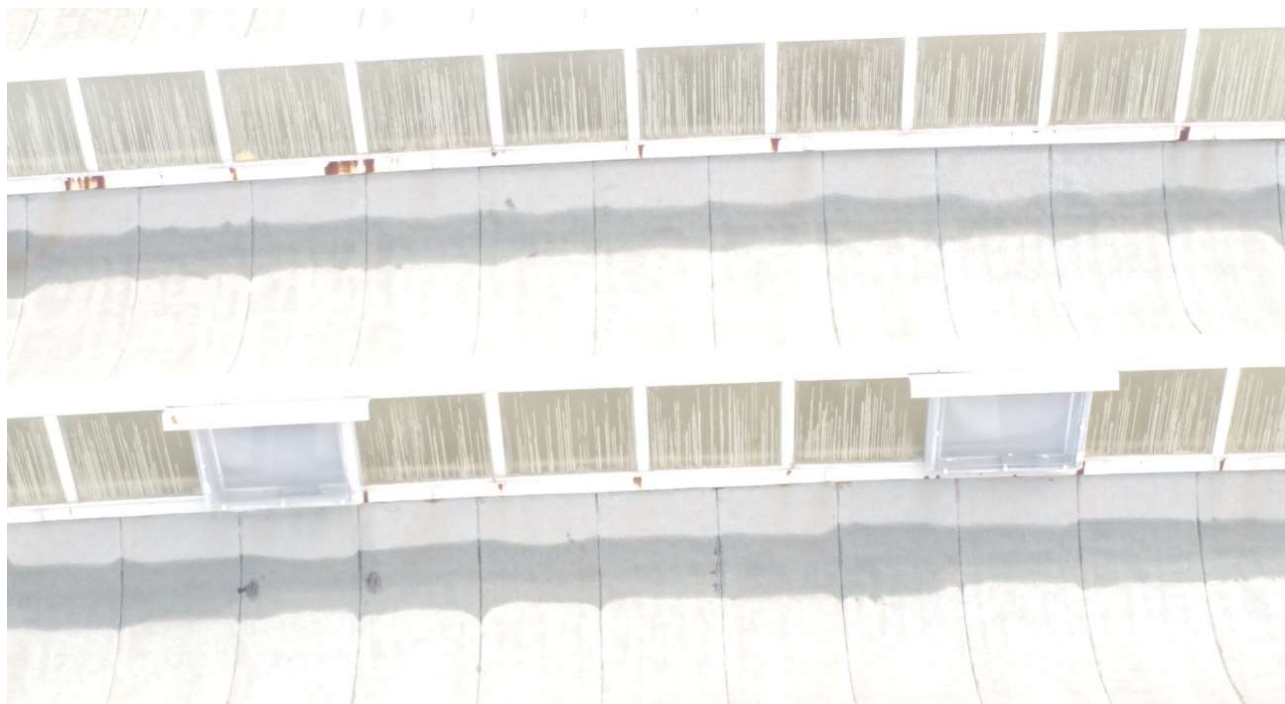
Figura 5: Particolare dello stato di fatto della copertura
